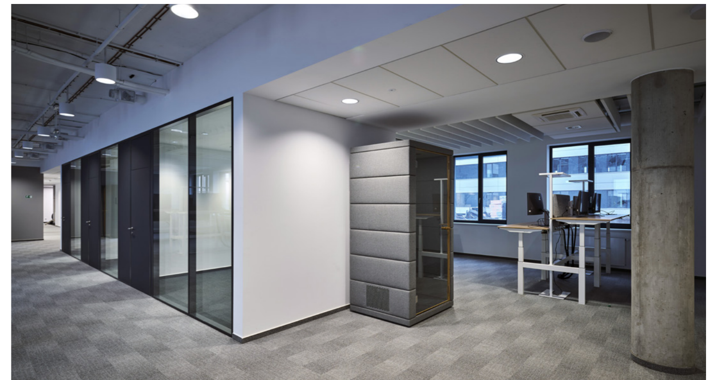
Dělicí příčky W112 jsou z jedné strany opláštěny dvěma deskami Knauf Diamant a z druhé strany dvěma deskami Knauf Silentboard
