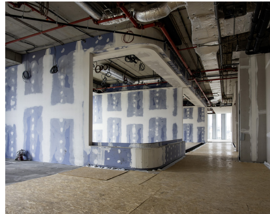
Desky Diamant i ve tvarované přičce umí zajistit potřebný akustický komfort
