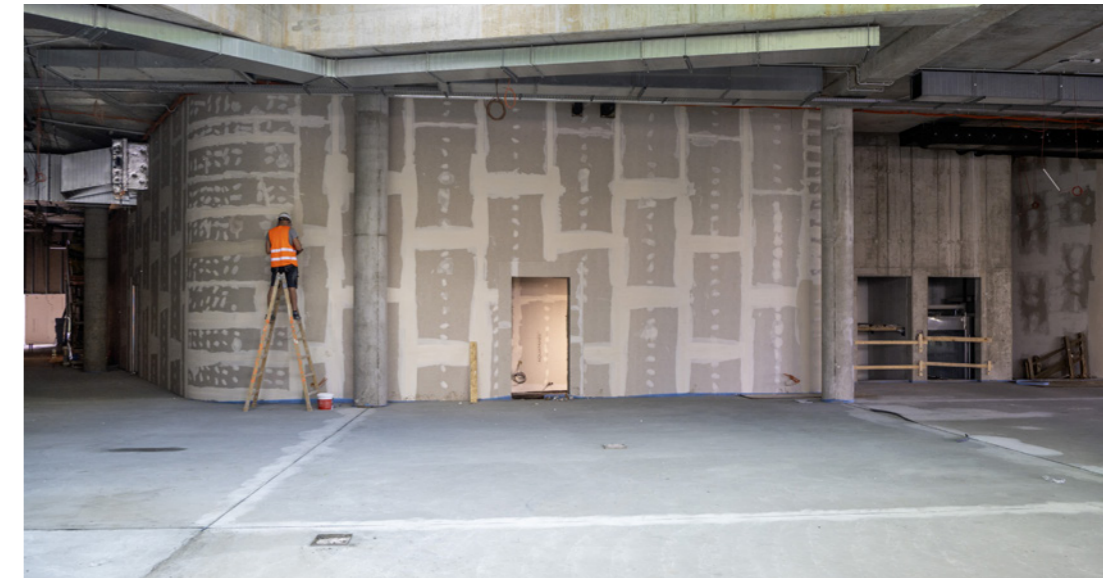
Z důvodu akustiky pomohly v případě kongresového sálu desky Knauf Silentboard
