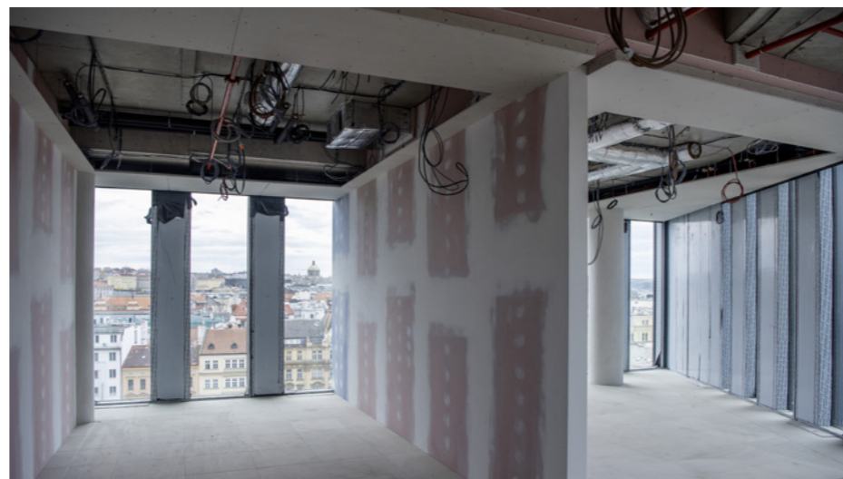
Suchá výstavba se musela vypořádat s nejednou složitou situací. Vrásky zpracovatelské firmě nadělala například množství akustických kastlíků.
