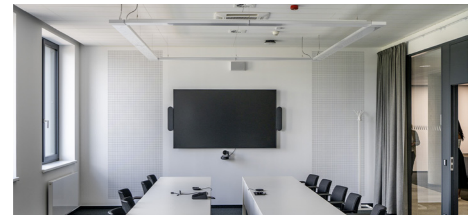
Kancelář s audio-video technikou má u příčky předstěny s vloženou akustickou deskou Cleaneo
