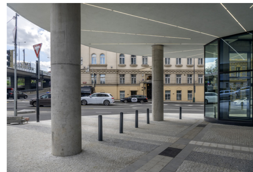
Všechny podhledy v exteriéru jsou zaklopeny cementovými deskami Knauf AQUAPANEL
