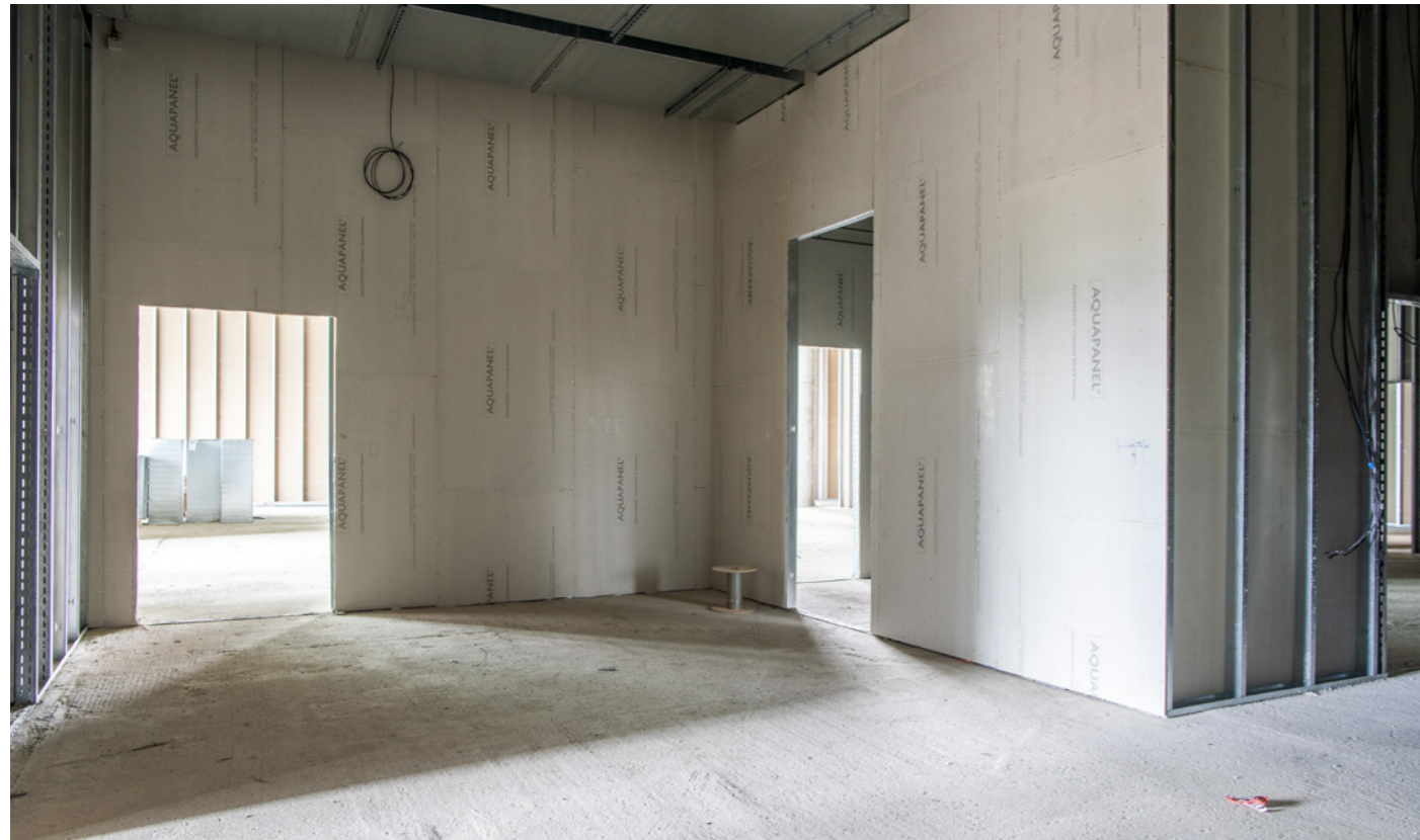
V gastro provozu se využily vlastnosti cementových desek Knauf Aquapanel Indoor - hlavní důvod: odolnost vůči vlhkosti
