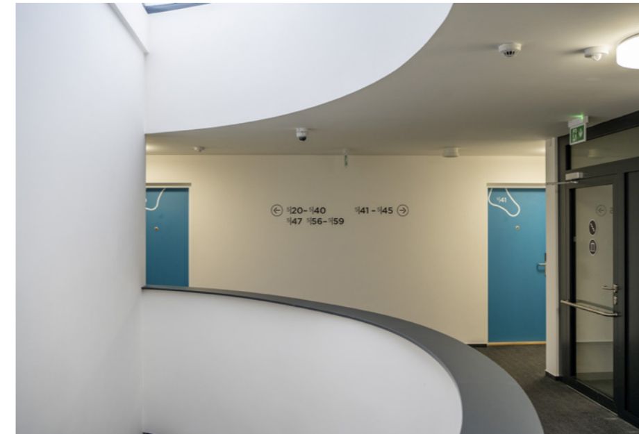
Krásně tvarované oblouky. Většina příček je konstrukce s tradičními deskami Knauf White
