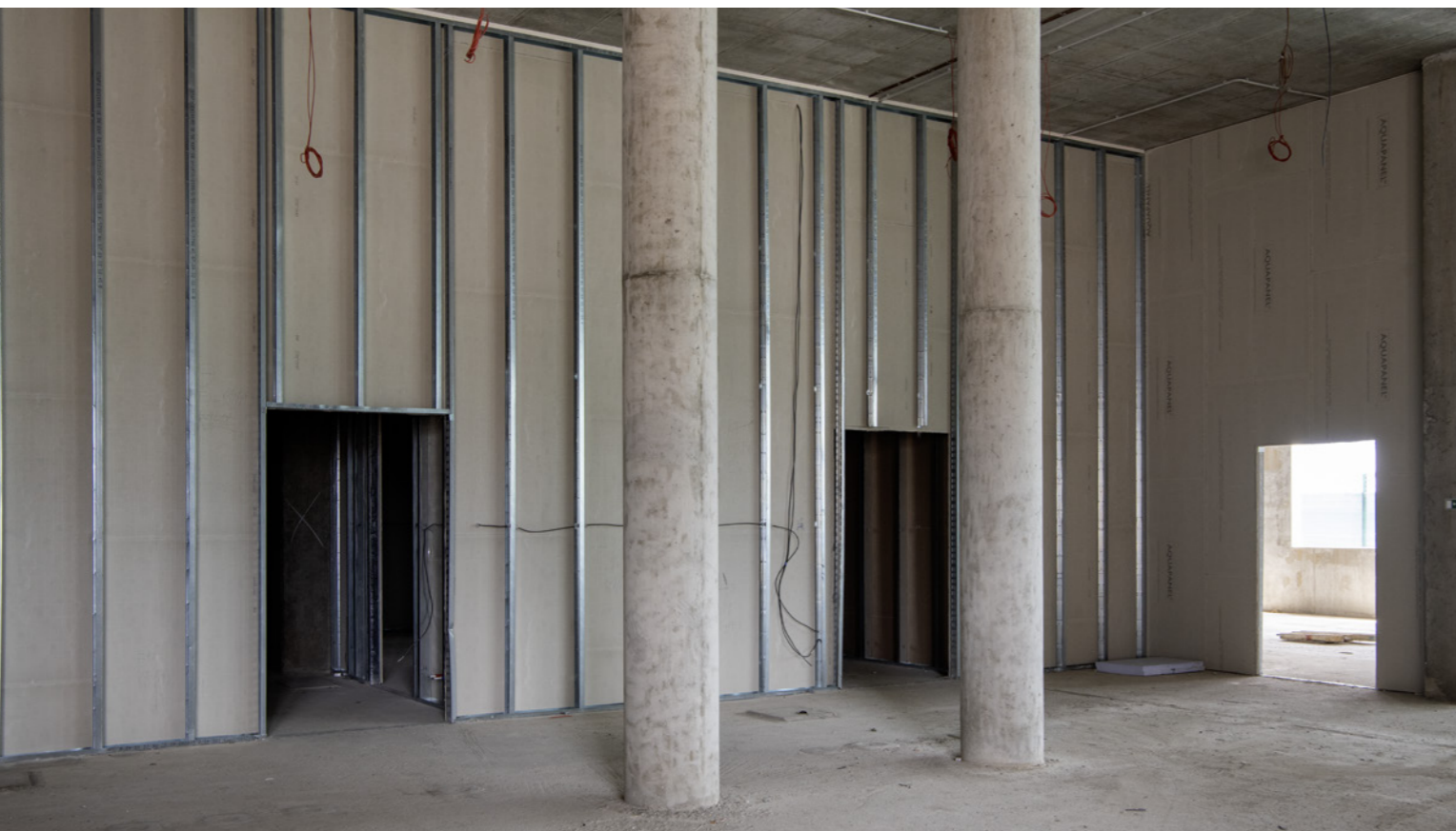
Aby mohl v přízemí vzniknout gastro provoz, bylo nutné nejprve postavit pevný korpus a na něj následně navázat příčky
