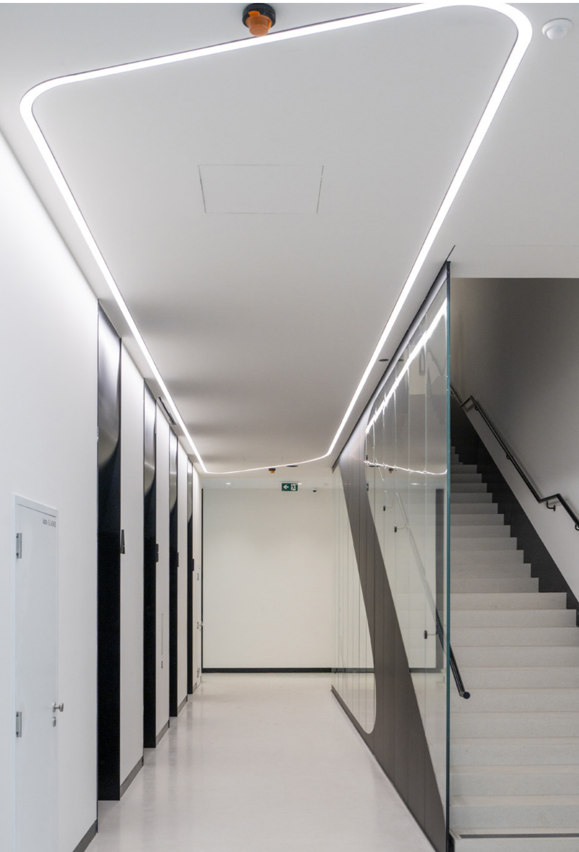
Sádkartonový pohled s designovým osvětlením v přízemí objektu
