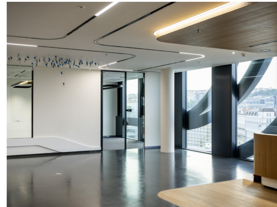
Sádkartonové designové podhledy s integrovaným osvětlením
