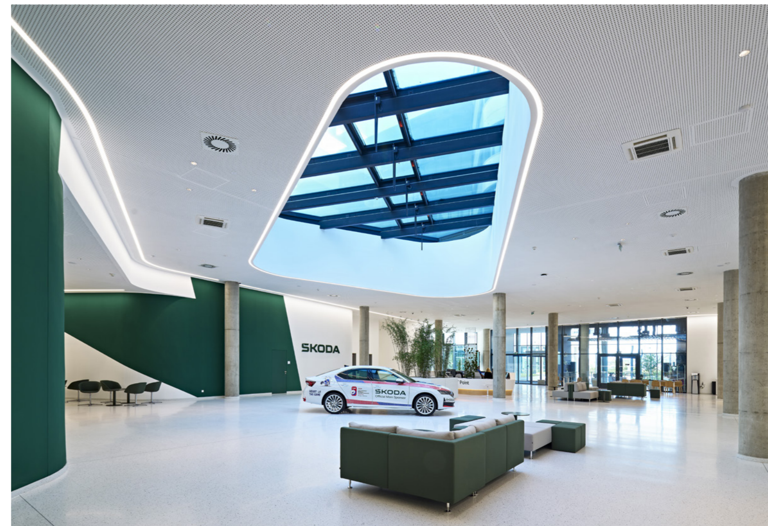
Nová recepcie s akustickými děrovanými podhledy Knauf Cleaneo
