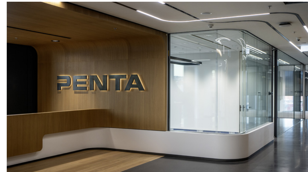
Téměř hotová recepcce investora. Na konstrukcích se nešetřilo a téměř všude jsou desky Diamant
