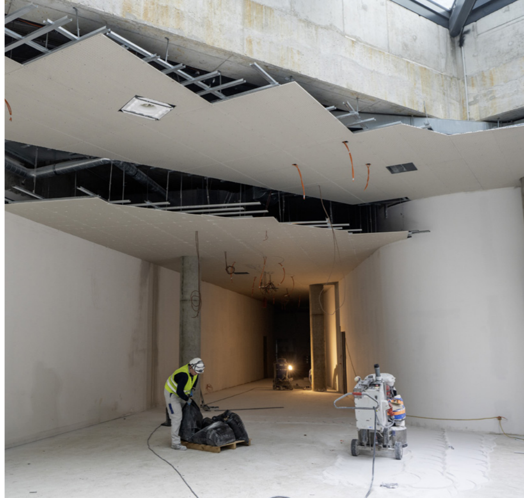
Stavba akustických podhledů v recepci s děrovanými deskami Cleaneo
