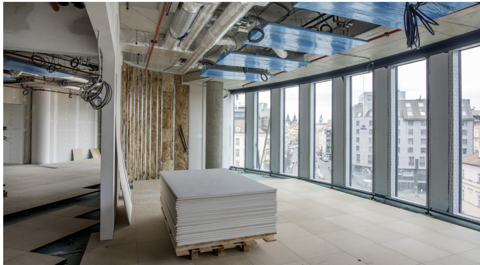
Jednotlivé fit-outy jsou odděleny místy bezpečnostními a protipožárními příčkami
