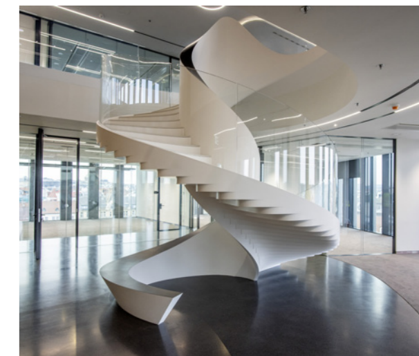
Organické křivky byly tvarovány z Corianu a navazovaly na suchou výstavbu
