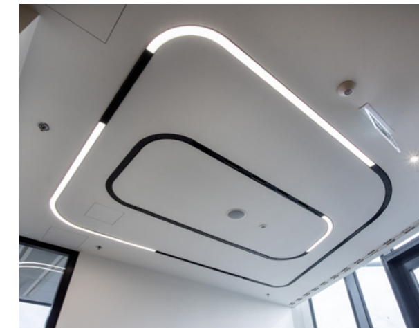
Sádkartonové designové podhledy s integrovaným osvětlením
