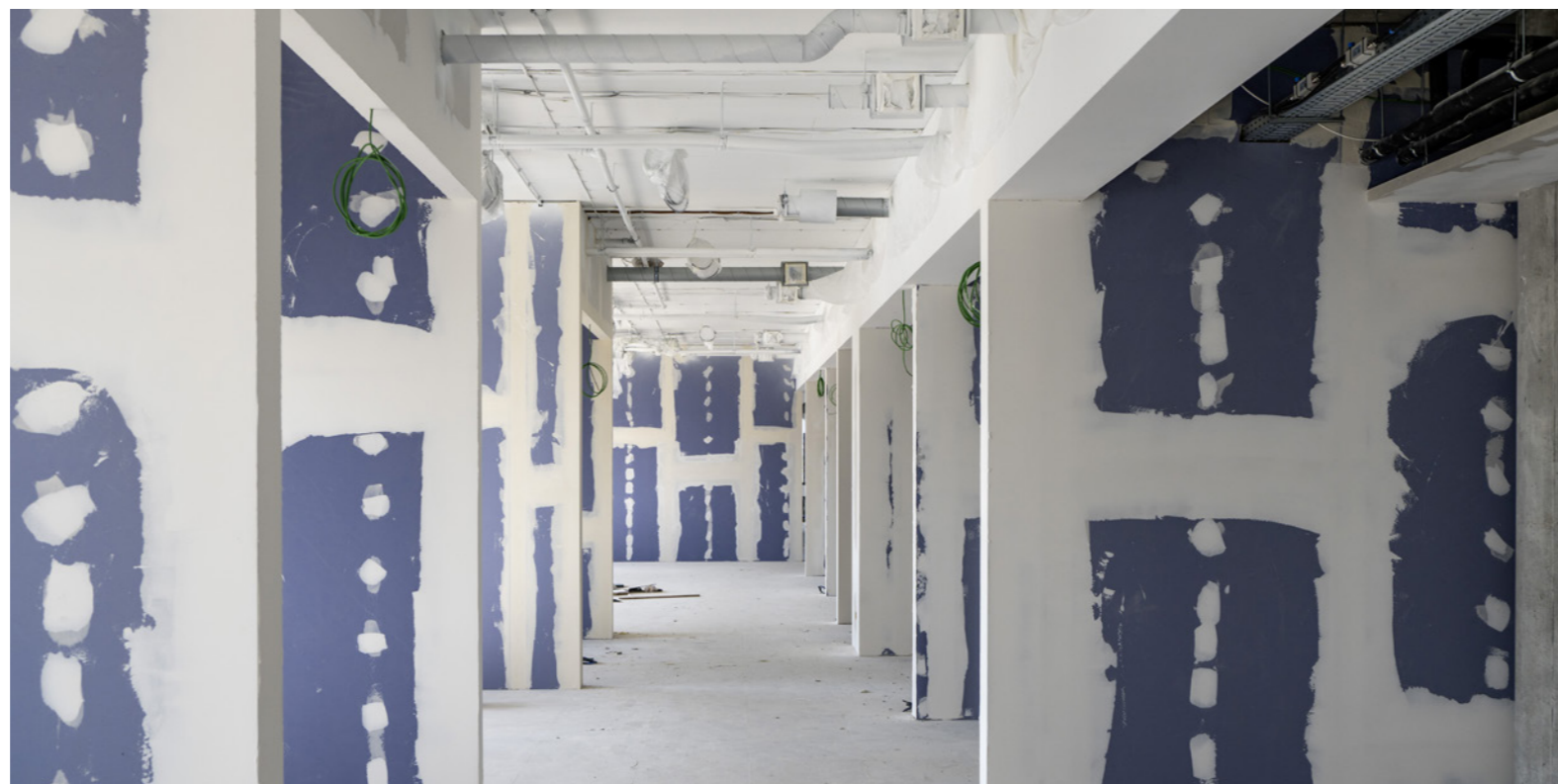
Dělicí příčky v kancelářských prostorech, kde desky Knauf Diamant doplňoval Silentboard ( R_w = 58 dB)
